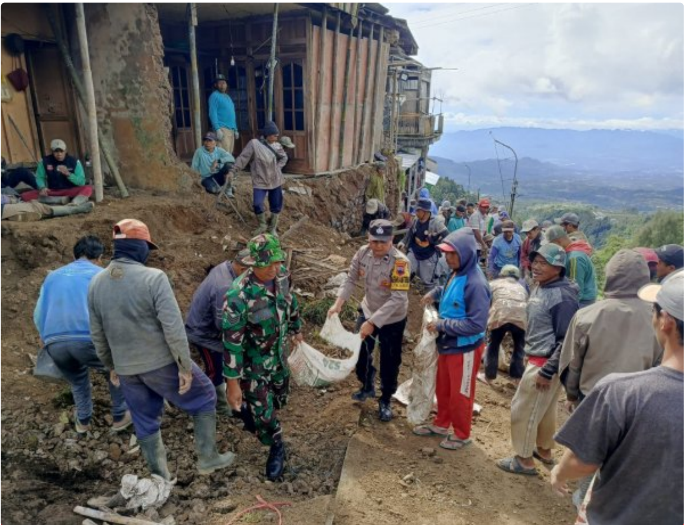
(Foto Dokumen) : Gotong royong pembersihan material longsor
